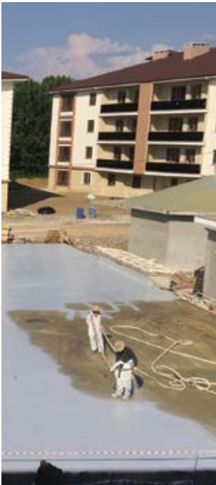
Foundation and curtain concretes Hormigones de cimentación y cortina
