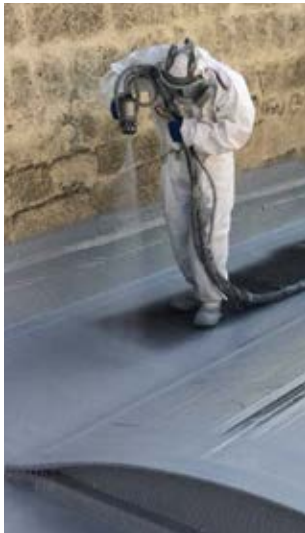
Roofs, Balconies and Terraces Канализации и станции очистки сточных вод
